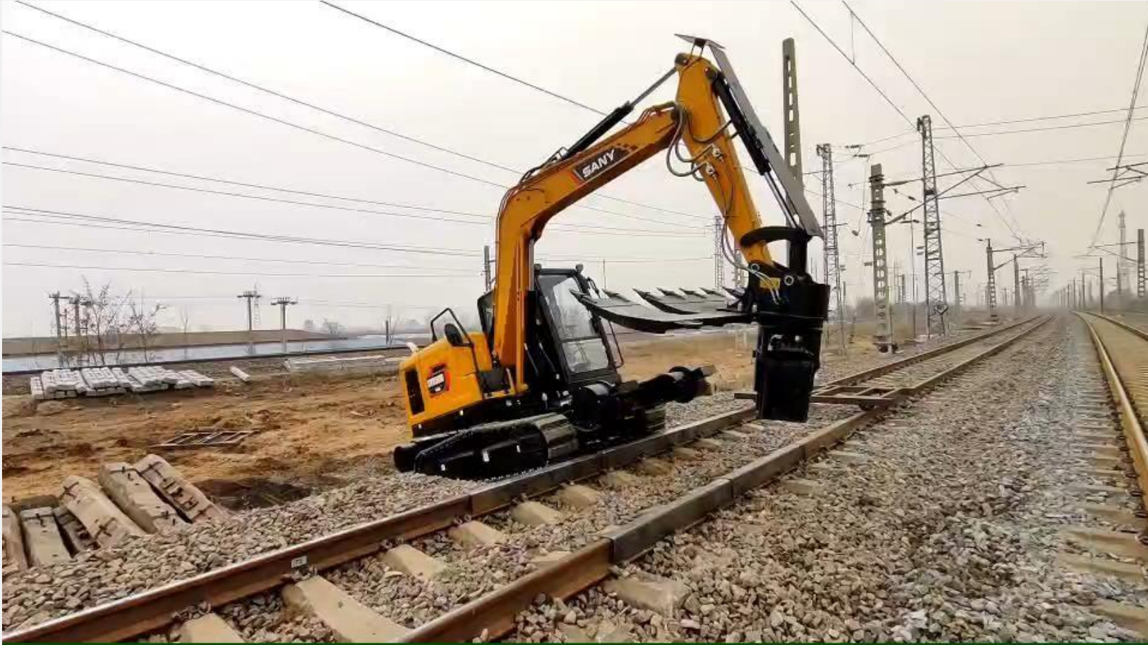
Máy SY85C đang thi công xây dựng đường sắt
